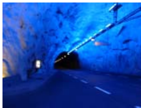
図 2 . トンネル内部の広い空間
